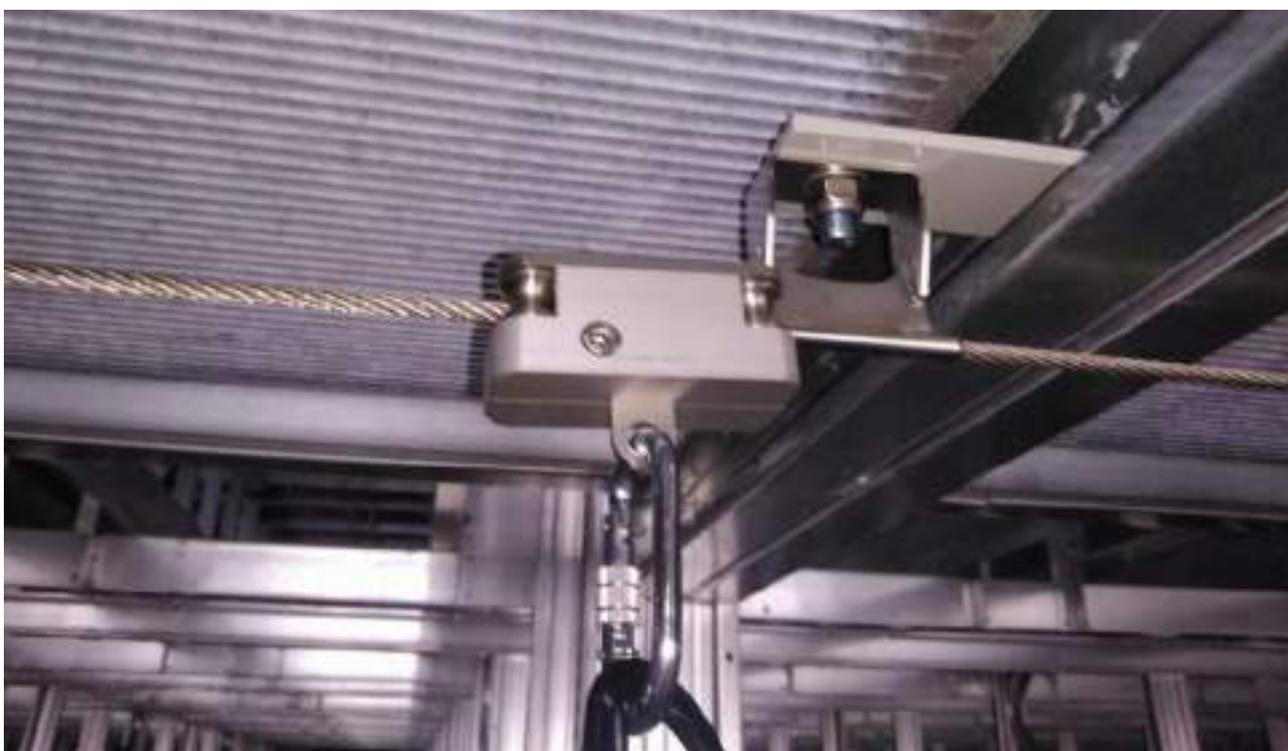
livello intermedio – linea di ancoraggio EN-795-C Rothoblaas PATROL PASS-THROUGH AIR punto intermedio passante PASINT installato su staffa dedicata e carrello passante SLIDE-3
