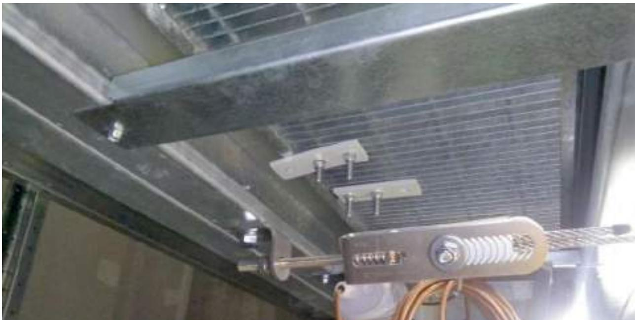
livello intermedio – partenza della linea di ancoraggio EN-795-C Rothoblaas PATROL PASS-THROUGH AIR tenditore-assorbitore SPEAR non ancora tensionato – distanziali di rinforzo della trave di supporto
