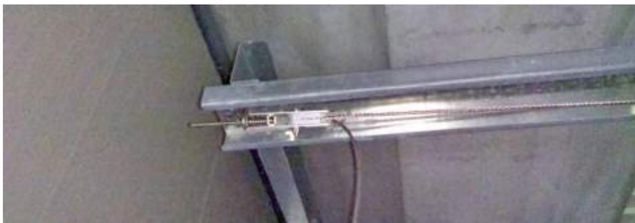
livello TOP – arrivo della linea di ancoraggio EN-795-C Rothoblaas PATROL PASS-THROUGH AIR
