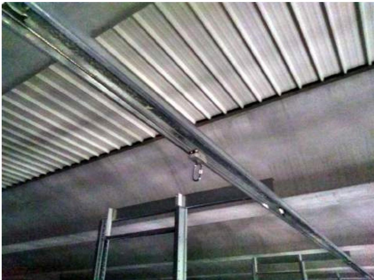
livello TOP – linea di ancoraggio EN-795-C Rothoblaas PATROL PASS-THROUGH AIR
