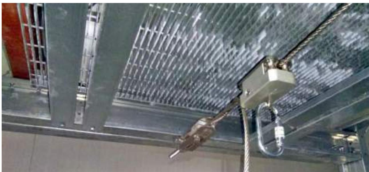
livello intermedio – arrivo della linea di ancoraggio EN-795-C Rothoblaas PATROL PASS-THROUGH AIR
