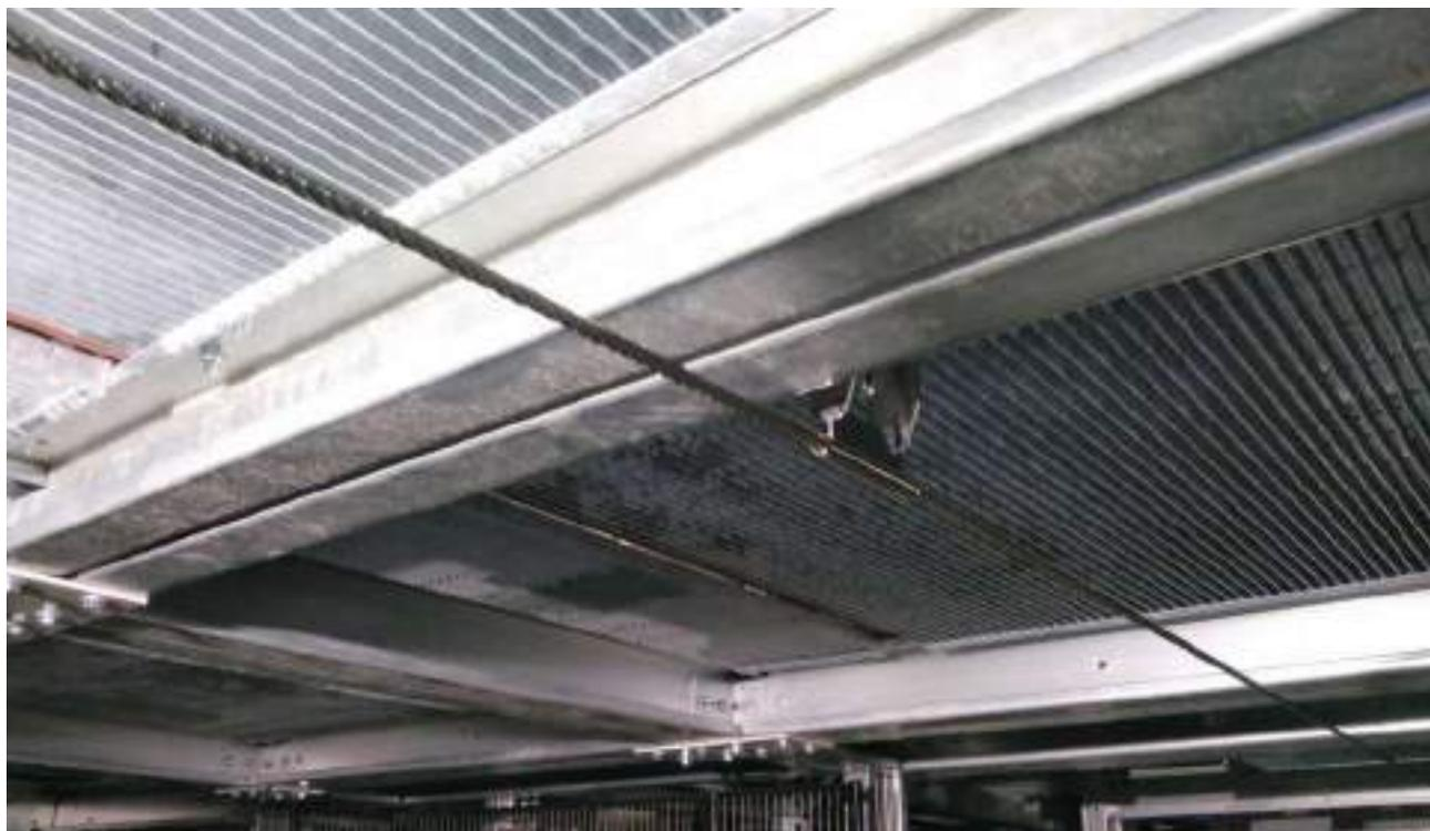
livello intermedio – linea di ancoraggio EN-795-C Rothoblaas PATROL PASS-THROUGH AIR
