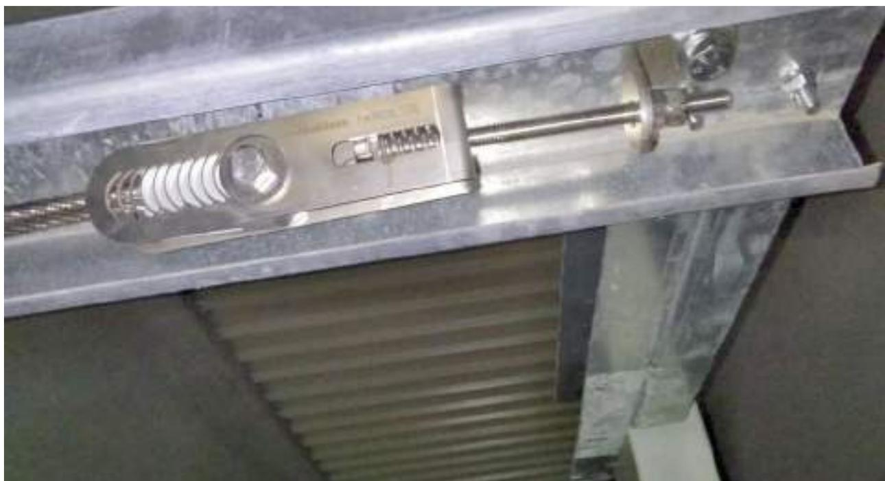
livello TOP – partenza della linea di ancoraggio EN-795-C Rothoblaas PATROL PASS-THROUGH AIR
